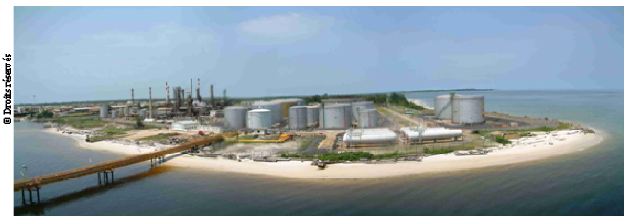
Raffinerie de Port Gentil
